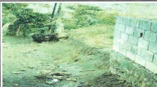
Foto 2: Vista del lugar afectado donde estaba el muro
